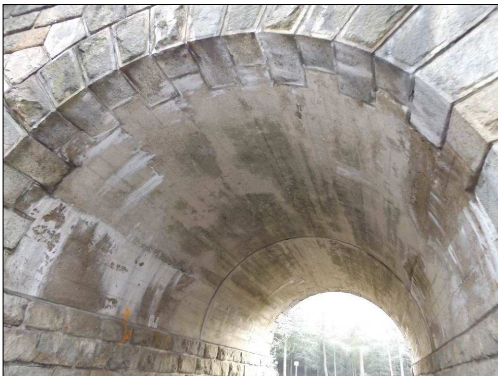
Obr. č. 7 - pohled na NK objektu. V levé části fotografie jsou patrné průsaky vody s tvorbou karbonátových usazenin v líci betonu.
