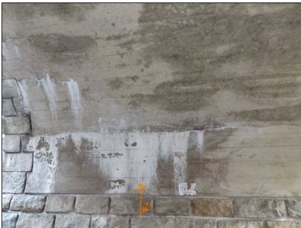
Obr. č. 9 - detailní pohled na průsaky vody skrze beton klenby.
